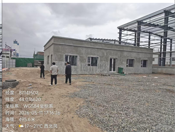
项目区西内原有建筑
