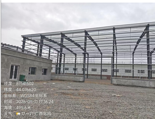
项目区西内原有建筑
