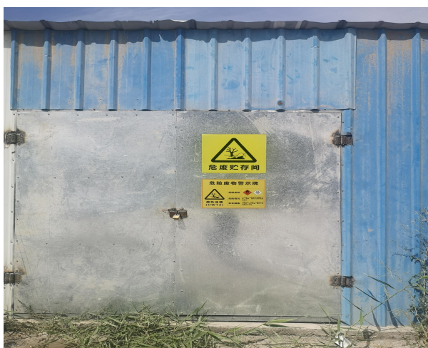
厂区现有危废暂存间
