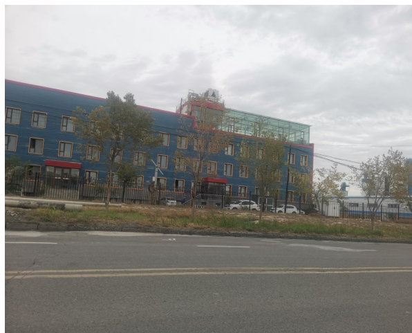
厂区南侧新疆万通人钢结构有限公司
