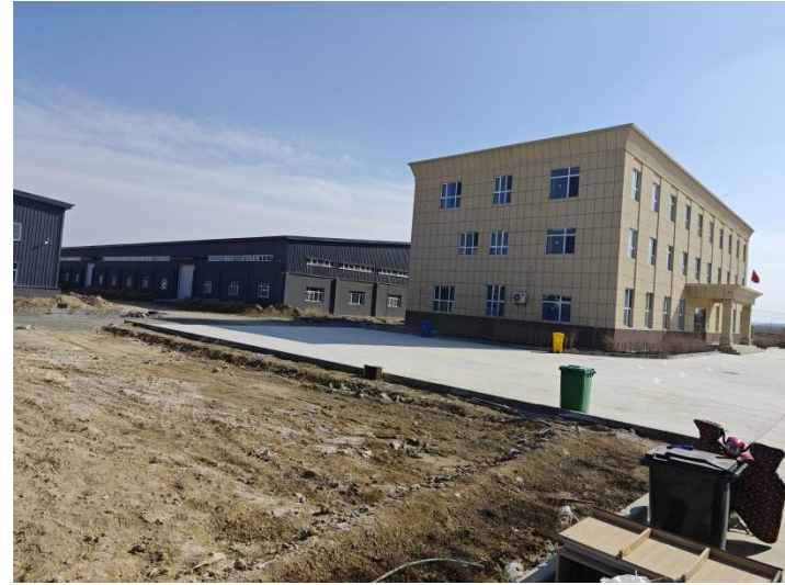
现有工程办公楼及生产车间
