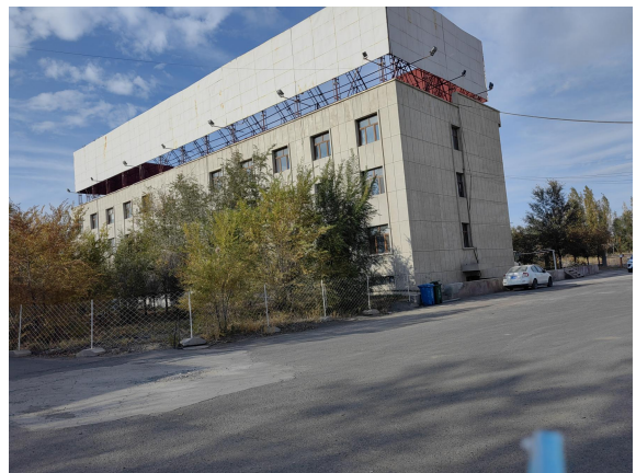
现有工程已建办公生活区
