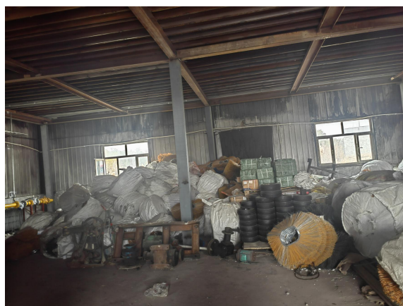
锅炉房内部现状
