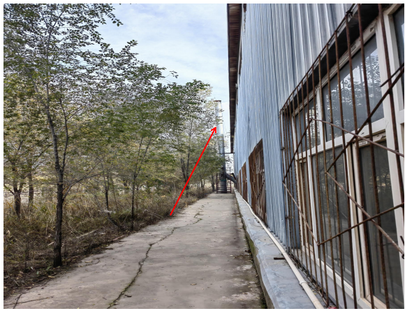
喷漆废气排气筒
