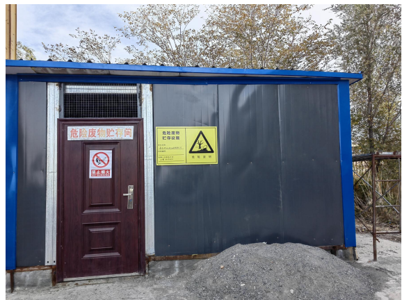
现有工程已建危废暂存间
