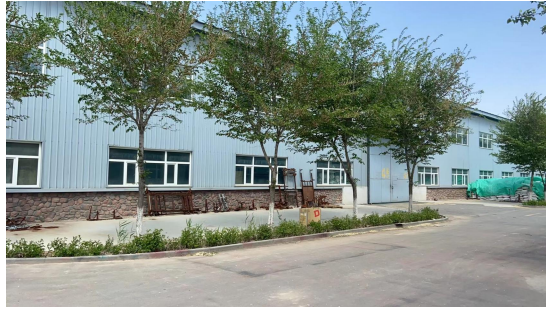
项目厂房外北侧为厂区道路和昌吉市普州教学设备有限公司
