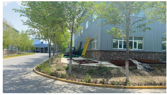
项目厂房外南侧为厂区道路和新疆飞达路交通安设施有限公司
